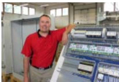
Algol Technics Oy:lle toimittamamme sähkö- ja ohjauskeskukset on tehty pääosin Satmaticin Keravan tehtaalla, kertoo alue- ja myyntipäällikkö Jani Heikkinen
